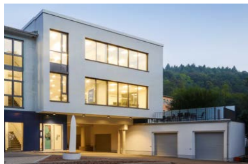
Bekanntnis zu Heimat und Produktionsstandort: Die 2020 erweiterten Produktionsgebäude in Glashütte. / A sign of commitment to our origins and production location: our production facility in Glashütte was expanded in 2020.
